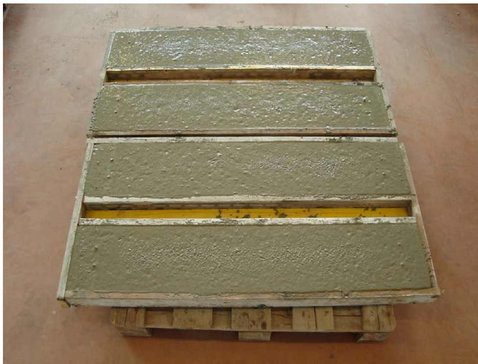
Fig. 2 - Vista d'insieme di alcune lastre vincolate dopo il getto del calcestruzzo
