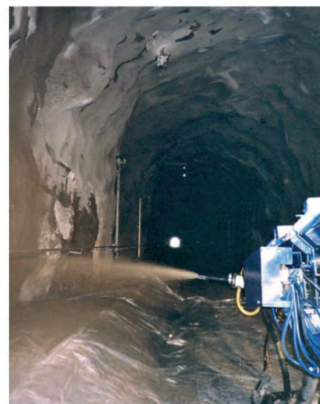
Fig. 4 – Applicazione del Penetron®
