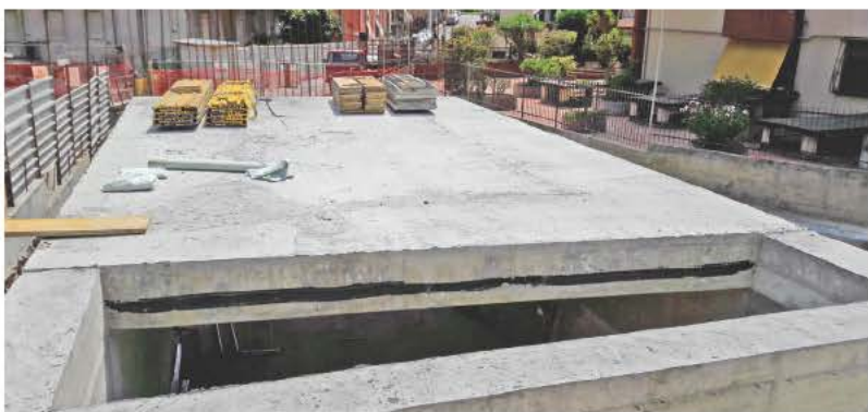
3. Uno scolare a spinta terminato, con il rostro per l'avanzamento
