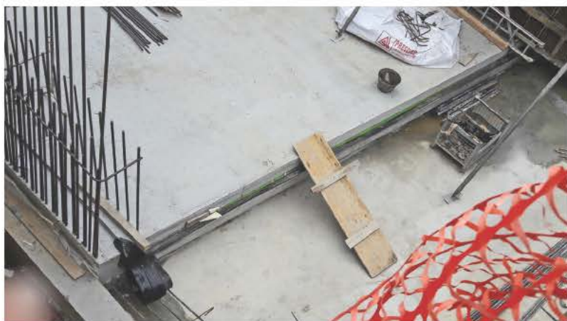
1. La realizzazione della platea del monolite a spinta con PVC inserito
